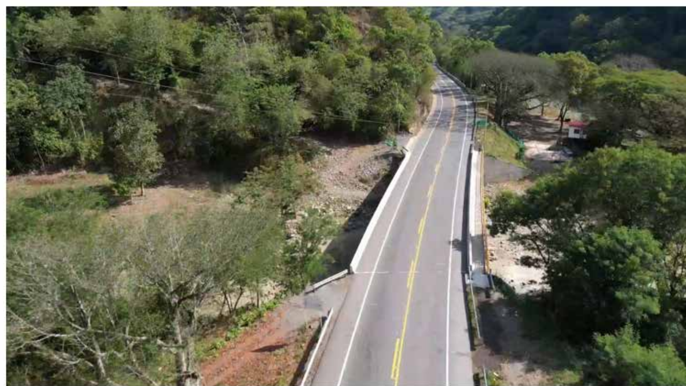
Ilustración 8. Sector K78+300 Puente Arquía - Unidad Funcional 5.
