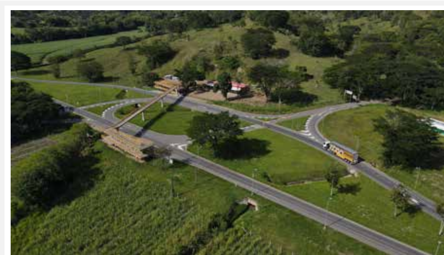
Intersección Entrada a Viterbo
