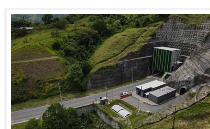
Túnel de Tesalia
