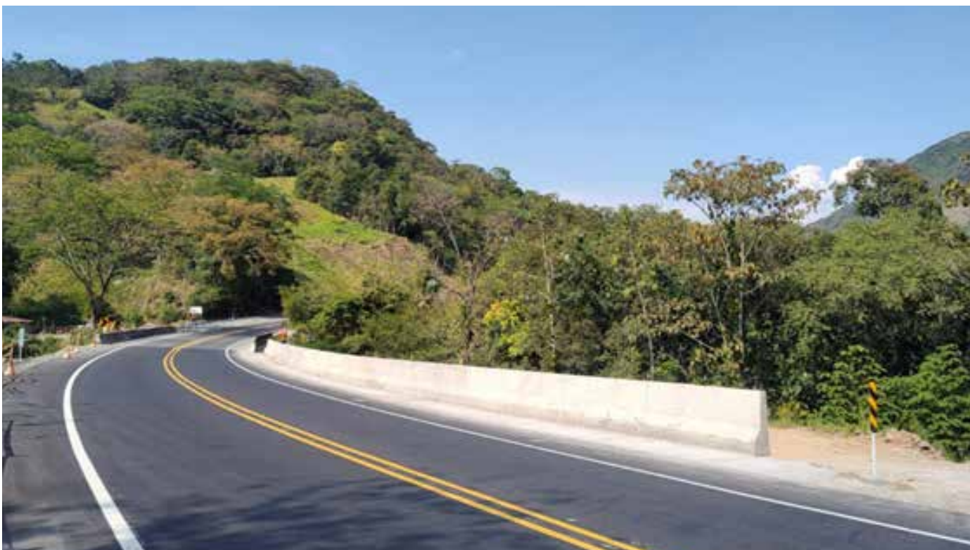
Ilustración 13. Puente K105+550 antiguo sector La Bocana - Unidad Funcional 5.
