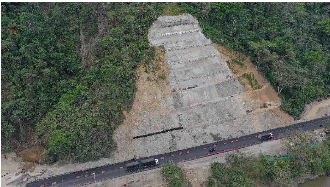
Ilustración 14. Estabilización talud K105+700 antiguo sector La Bocana - Unidad Funcional 5.
