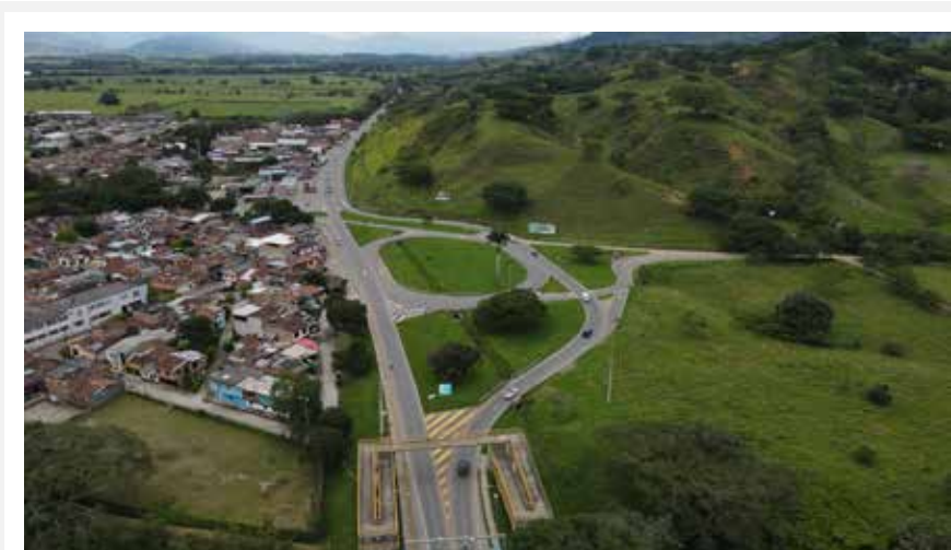
Intersección Calle Tercera
