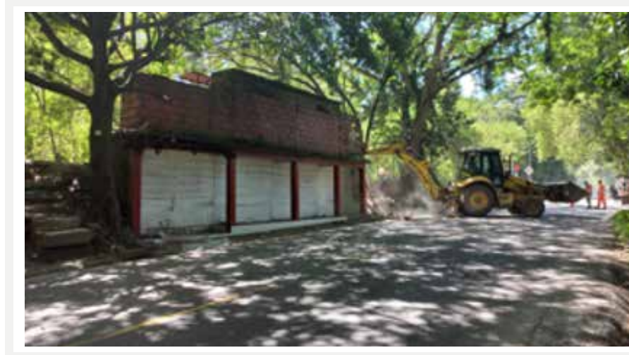
Demolición de puesto de piononos
