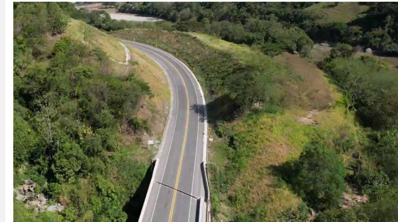
Ilustración 10. Sector K86+400 Puente 5 y corte en cajón- Unidad Funcional 5.
