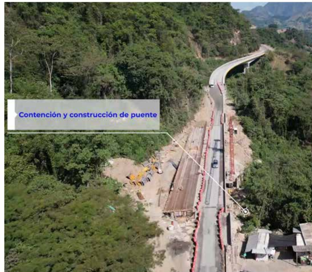
Ilustración 3. Puente C K90+630-K90+713 Unidad Funcional 5.
