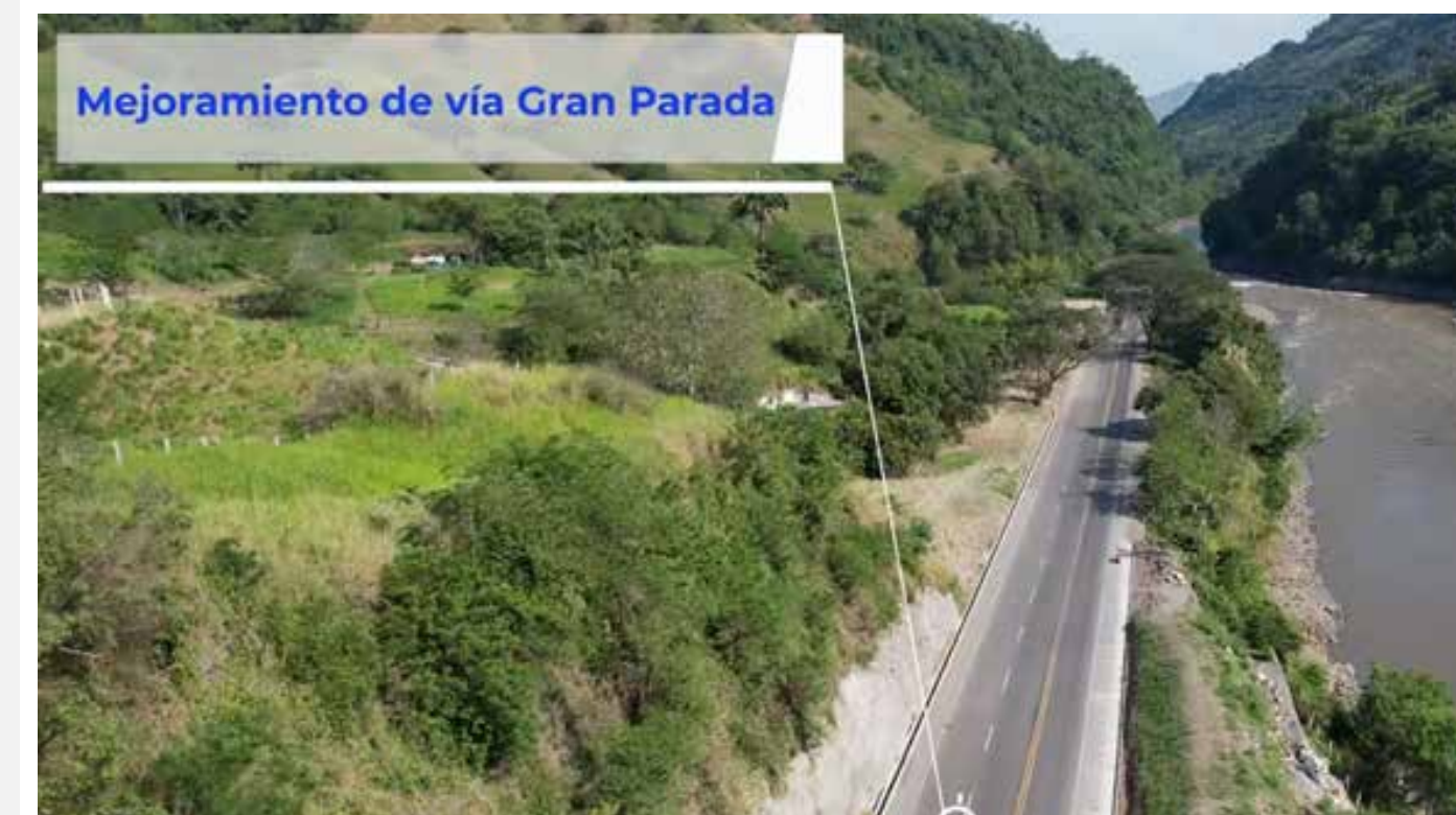
Ilustración 7. Sector K63+200 Gran Parada - Unidad Funcional 5.
