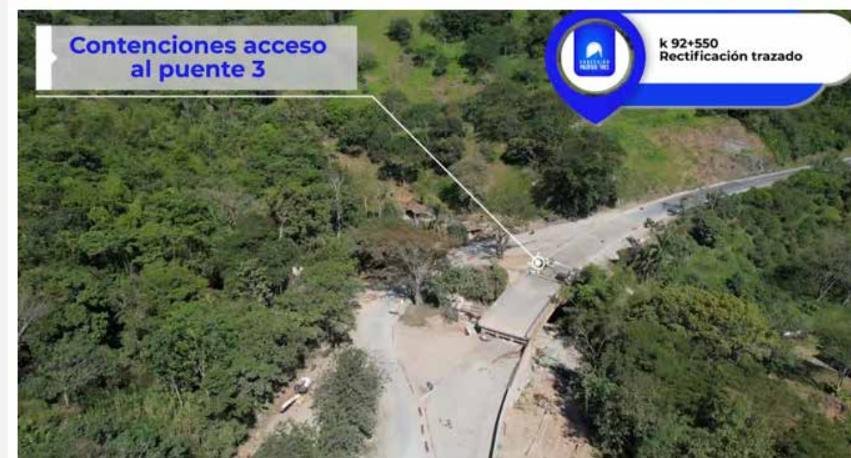
Ilustración 4. Puente 3 K92+500-K92+900- Unidad Funcional 5.
