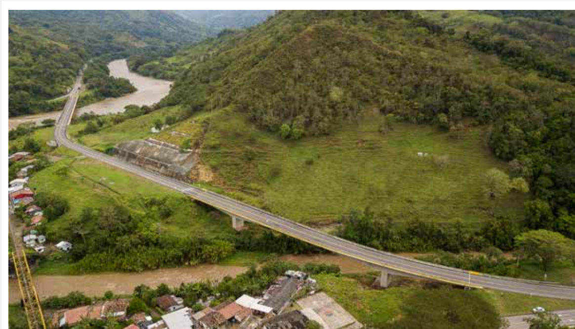
Puentes Cauca y Tapias
