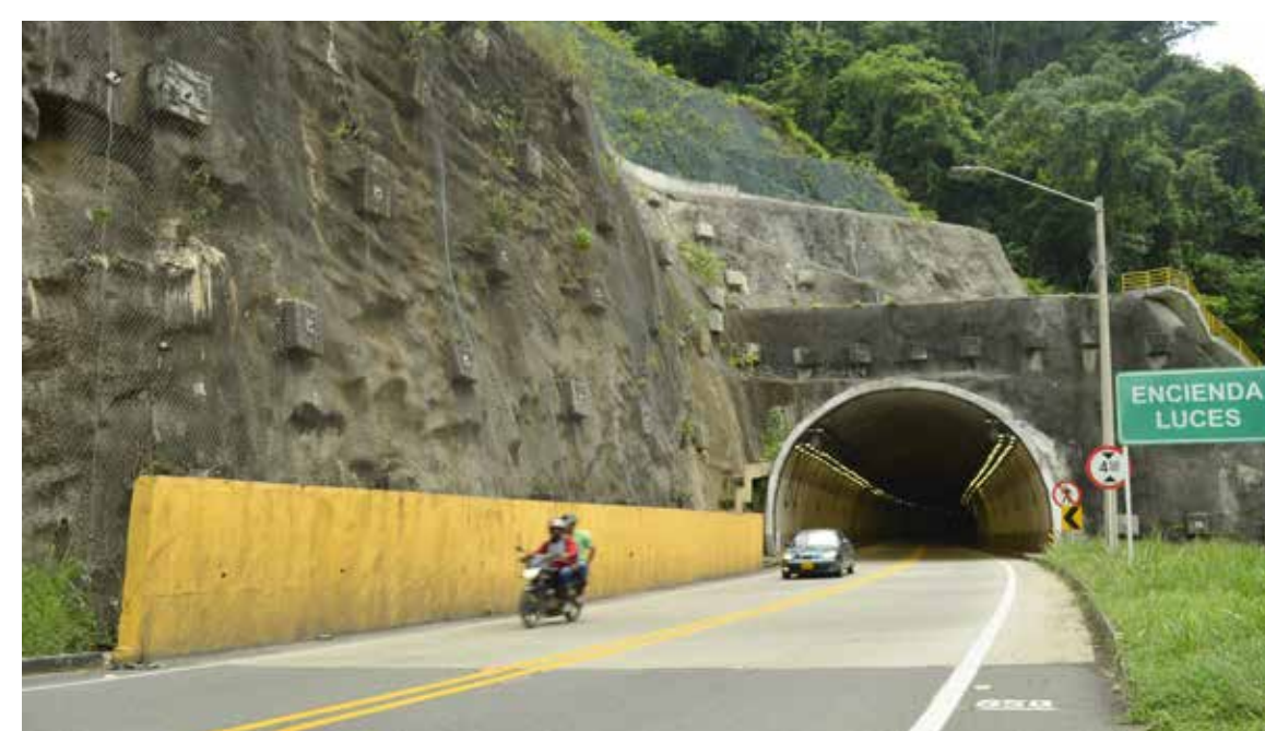
Túnel de Irra
