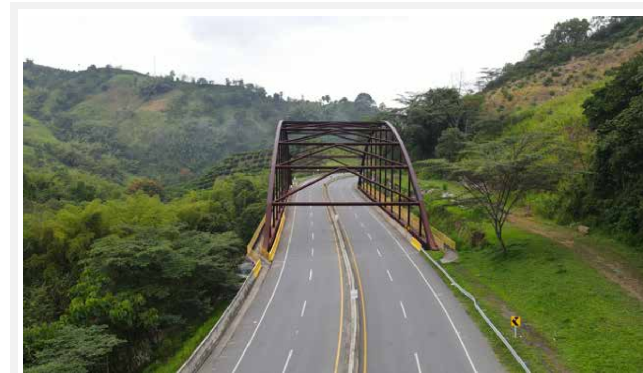
Puente Metálico La Manuela
