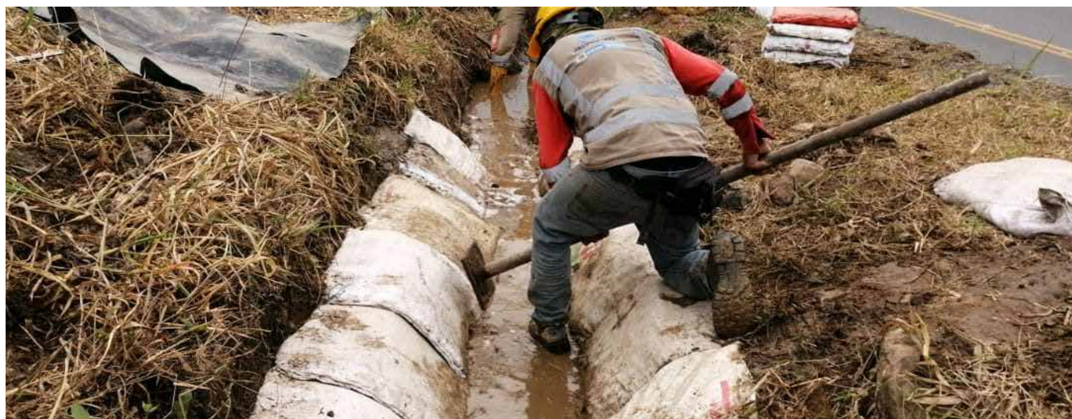
Limpieza de taludes y zanjas.
