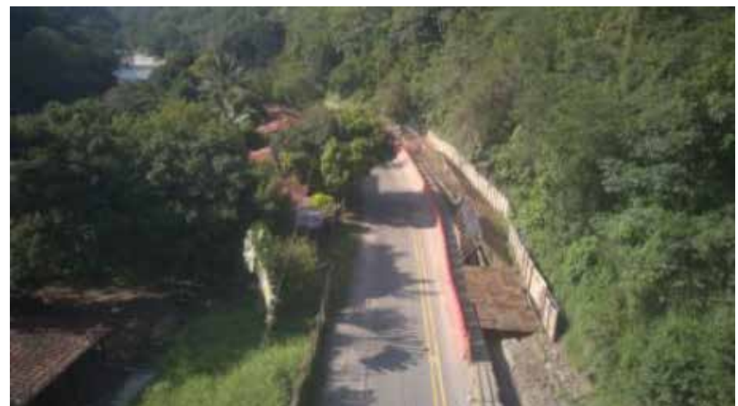
Traslado tubería Poliducto
