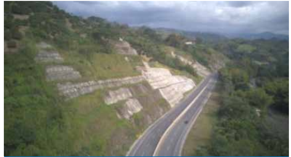
Estabilizaciones sector K6+100
