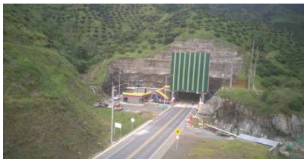
Portal salida túnel
