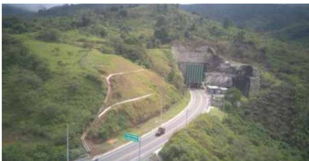
Portal entrada túnel
