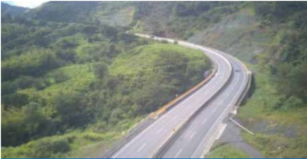
Estabilizaciones sector K3+500
