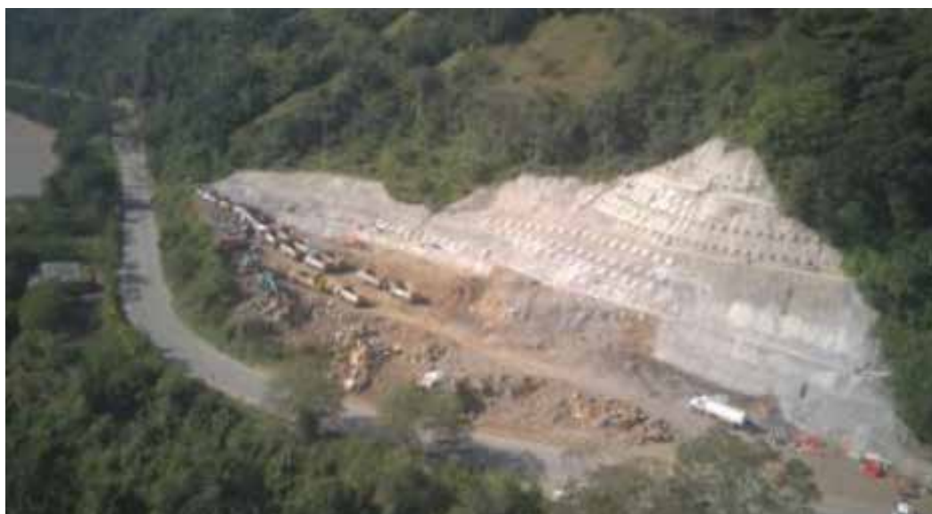
Estabilización talud K71+200
