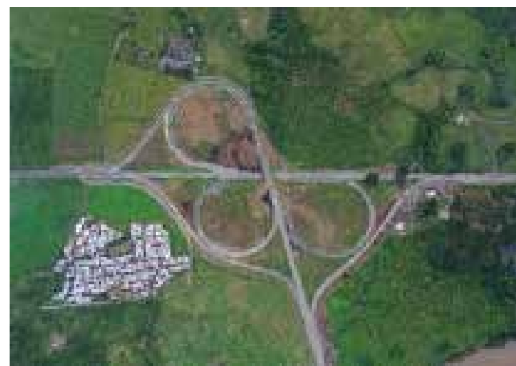
Fotografía aérea de la Intersección Tesalia construida en el sitio arqueológico El Indial.
