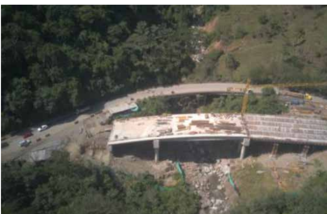
Construcción Puente 4 K98+452
