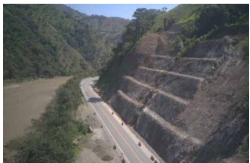
Estabilización Talud K98+300
