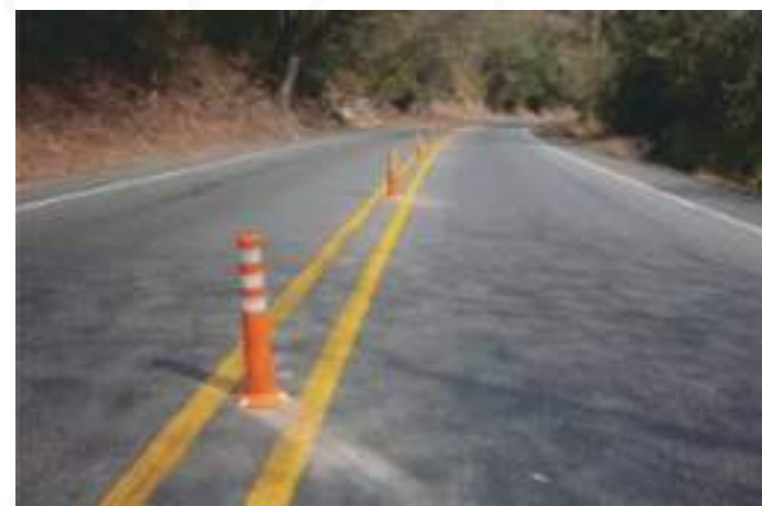
Fotos: Instalación de Hitos y Demarcación de elementos de la vía
