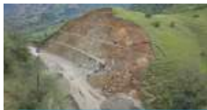
Corte de talud para mejoramiento geométrico
