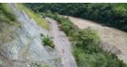
Corte de talud para mejoramiento geométrico
