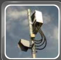
**13 Equipos de Detección Electrónica de Alturas**, para identificar vehículos que puedan ocasionar daños a la infraestructura.
